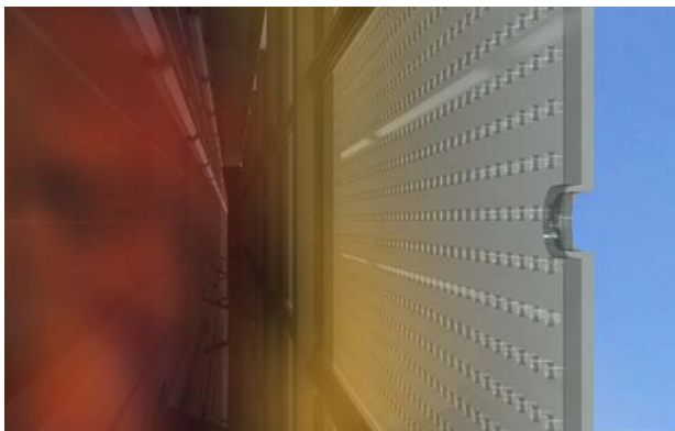
Promienie słoneczne przenikają przez panele i ogrzewają powietrze.
