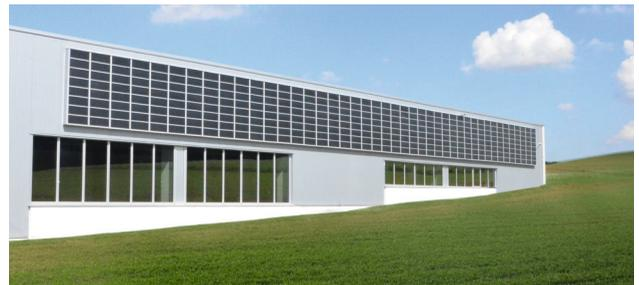
ßig Frischluft in die Anlage. Diese vermischt sich mit der warmen Luftschicht und erwärmt sich immer weiter an dem Absorber und sorgt so für einen gleichmäßig hohen Wirkungsgrad.
